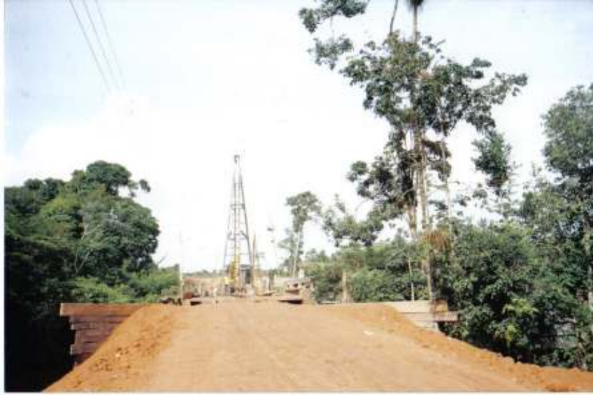
Estrada e ponte. Obras de recuperação.
