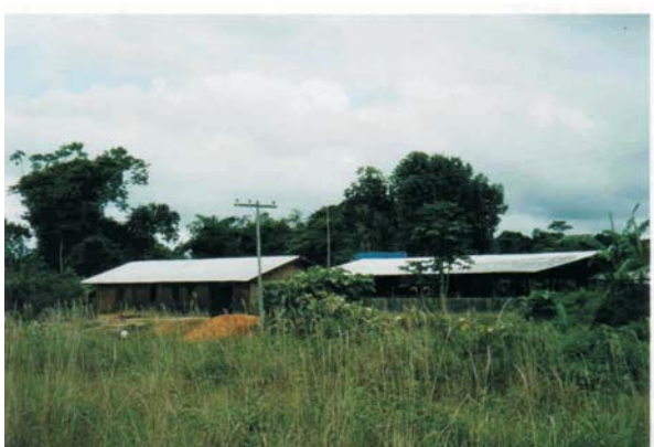
C. Casa sede à esquerda e hospital à direita
