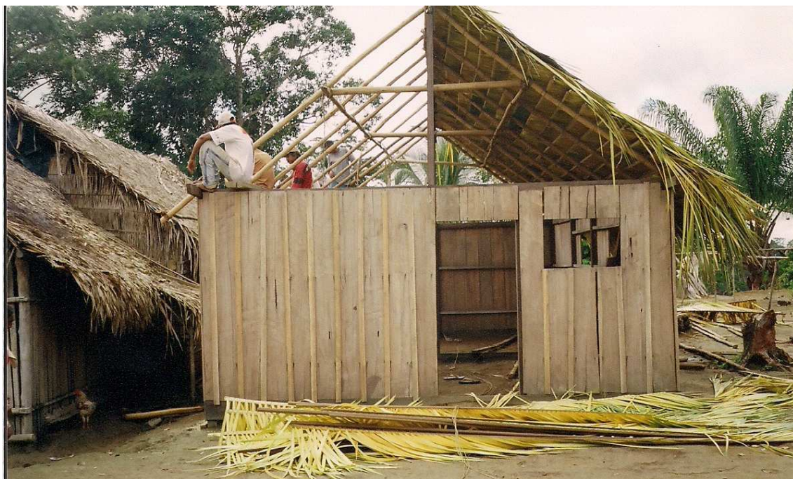
Foto 15: A construção da casa é uma das atividades que demanda mais esforços dos homens. Na área do Teles Pires, há palha de babaçu em quantidade para os telhados; no Rio dos Peixes, é preciso recorrer a “tabuinhas”
