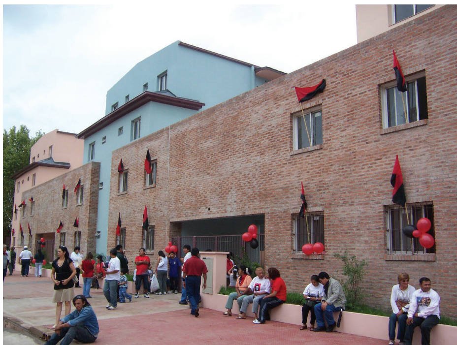
Pórticos de ladrillo a la vista. Fuente: A. G. Thomasz
